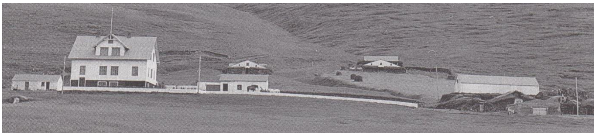
Húsakostur á Geitaskarði um 1946. Lengst til vinstri er smiðja með áföstum þurrkhjalli, þá íbúðarhúsið og sunnan við það tvö geymsluhús, byggð 1926 og 1930. Upp af þeim er torfbyggt fjárhús í fjallsrótum og annað fjárhús ásamt hlöðu sunnan við bæjarlækinn. Neðst til hægri er steinsteypt hlaða frá 1946 og vestan við hana þyrping peningshúsa úr torfi, þ.e. fjós, fjárhús og hesthús.
