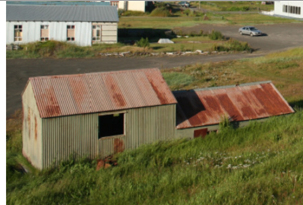
Mynd frá 2012 - Suðurhlöð að brekkunni
