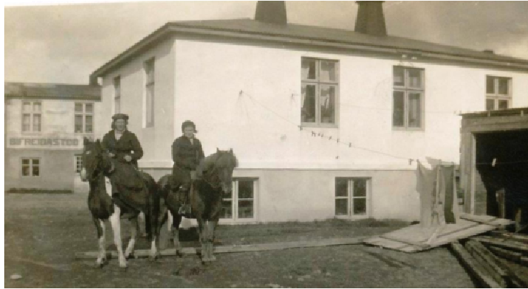
Hér sést á bakhlíð húss og skúr í byggingu t.h. (áo)
