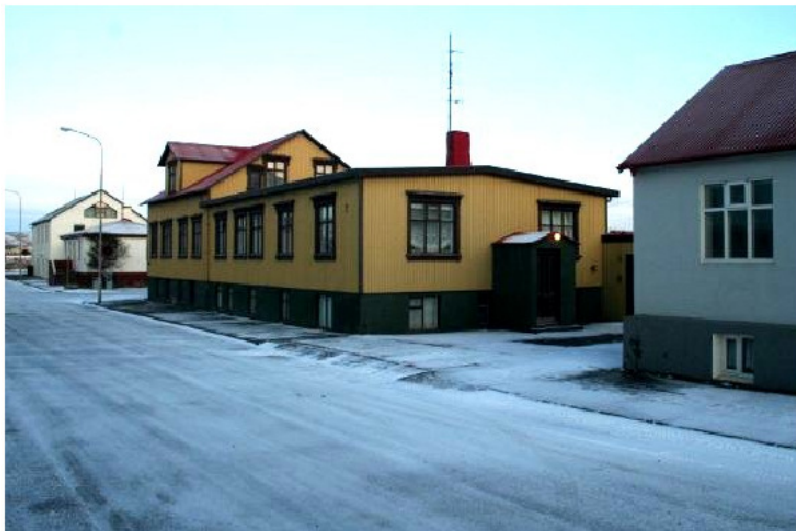
Aðalgata til norðurs að Blöndubýggð
